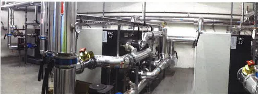
Les pompes à chaleur du fabricant Waterkotte permettent de récupérer 2 MW en chauffage et 1 MW en climatisation sur l'ensemble du site. La valorisation de l'utilisation en climatisation de la géothermie, notamment en géocooling, est également un enjeu important pour son développement en France.
