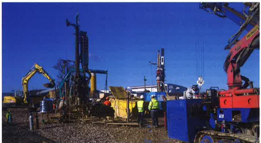
140 sondes géothermiques verticales (SGV) ont été réalisées sur le chantier. Elles s'ancrent à 205 mètres de profondeur et permettent de chauffer et climatiser environ 36 000 m<sup>2</sup> de bâtiment.
