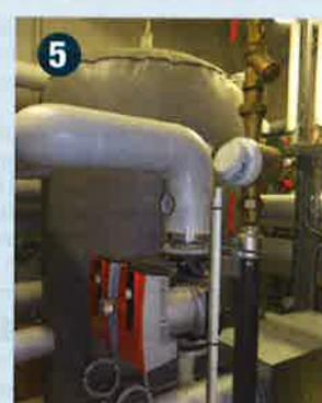
bâtiment et elle valorise cette énergie par l'intermédiaire la Pac eau-eau. Dotée d'un coefficient de performance de 4,5, cette dernière délivre une puissance calorifique de 207 kW avec un régime de 4/1 °C au primaire et de 40/45 °C au secondaire. Elle couvre les besoins de chauffage des bâtiments ainsi que le préchauffage de l'eau chaude sanitaire.
