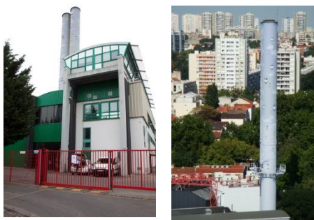
Chaufferie des Roses Source : Engie Réseau
