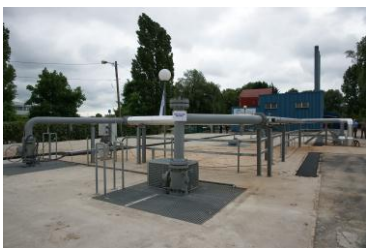
Extérieur de la centrale géothermique de Chelles
